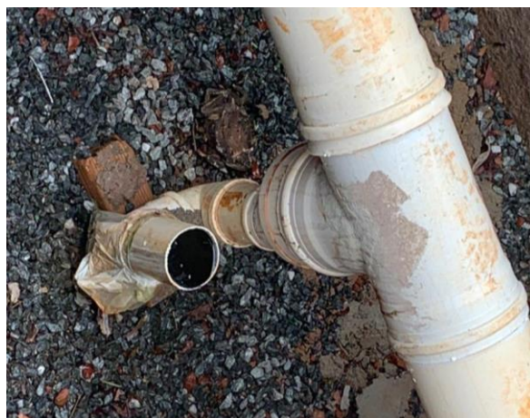
Figura 25 - Válvula para escape de gás e controle da pressão em um biodigestor tipo lagoa.
