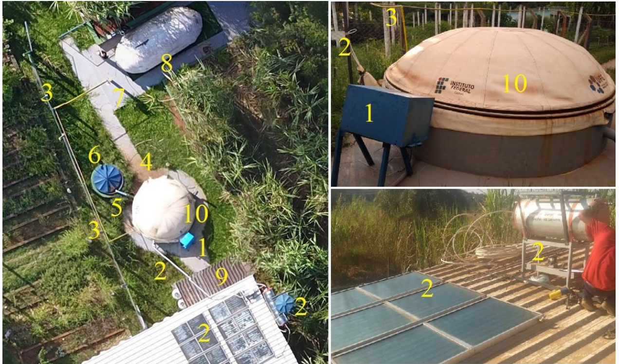
Figura 38 - Biodigestor CSTR no BiogasLab IFG-UFG.
