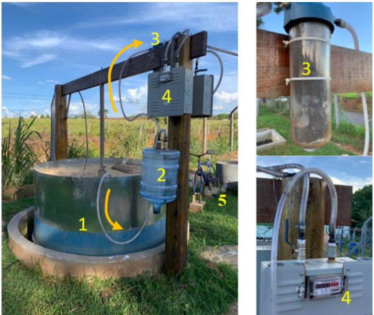
Figura 34 - Biodigestor Sertanejo implementado no BiogasLab IFG-UFG.
