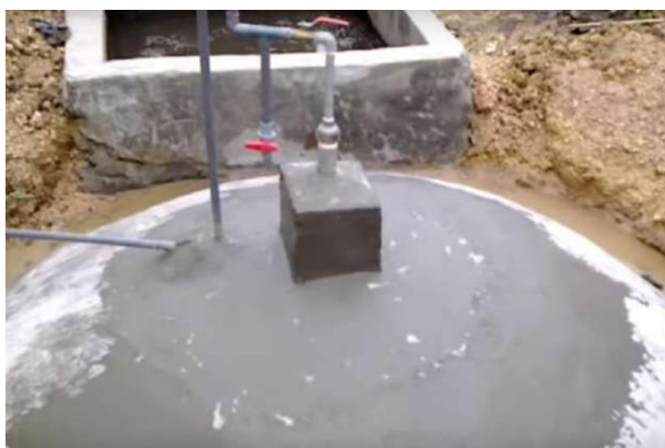
Figura 7 - Biodigestor tipo “Chinês” com cúpula fixa.
